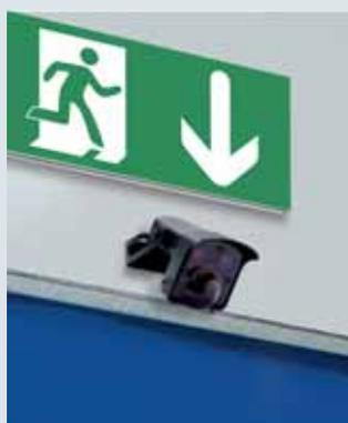
Detector por radar en dirección de escape, de serie
