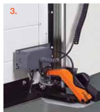
En las puertas con puerta peatonal incorporada sin umbral elevado, la célula fotoeléctrica antepuesta VL2 controla el canto inferior de la puerta con dos sensores. La protección contra colisión lateral impide que se dañe el brazo giratorio en la posición de puerta cerrada.
